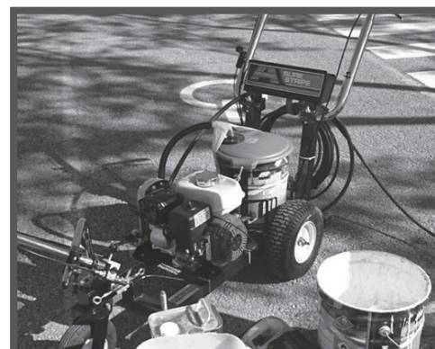
2015 RECUPERACIÓ ESPAIS VORERES
